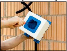
Elektrokabel oder Kabelschutzrohre durch die Aussparungen führen.
