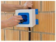
Die Elektrodosen Eldoline® 3772 anbringen und anschrauben. Befestigungsmaterial: Schrauben: Ø 4 x 40 mm, Dübel: Ø 5 x 24 mm
