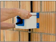
Kabelleitungen passend abschneiden. Werden keine Kabelschutzrohre verwendet, entfällt dieser Arbeitsschritt.
