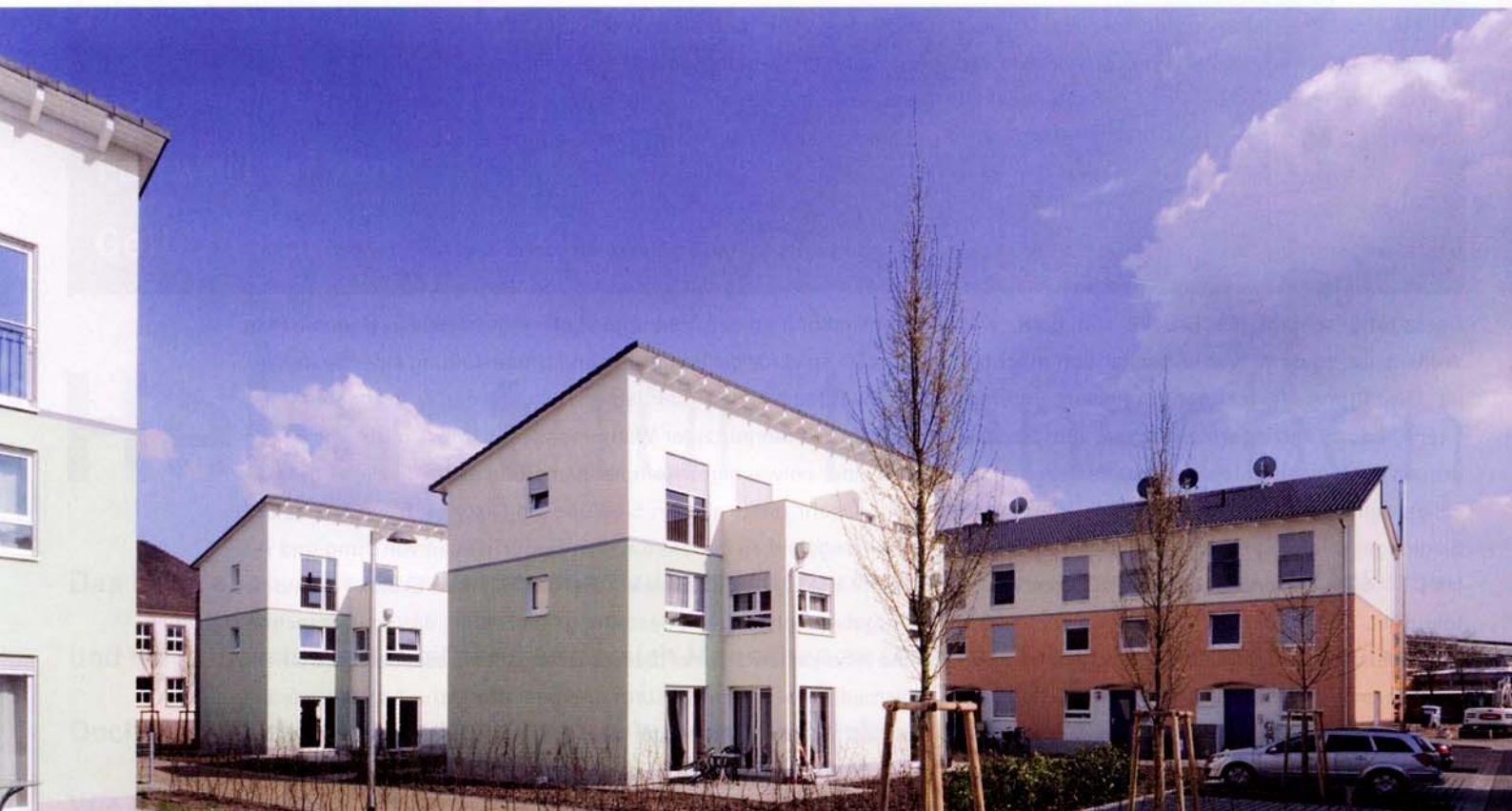
Neubausiedlung in Rüsselsheim: Ein helles Beige als Grundfarbe und farbig aufgemalte Gurtbänder verbinden die Siedlung
